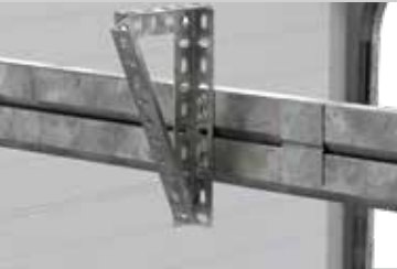
03 Cantonera perforada para fijación de las guías al techo.
