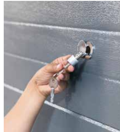
Desbloqueo de llave exterior (motor de techo)
